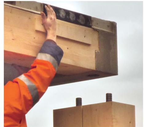
Abb. 20. Detail Auflager Decke HBV
